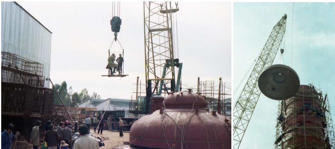
Momento previo a la erección de la tapa y su elevación.
